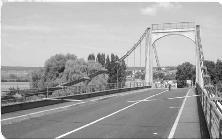
**1981** - La rupture d'un câble amène le remplacement de tous les câbles (jugés trop peu résistants) et nécessite ainsi la fermeture du pont à la circulation durant 6 mois.
