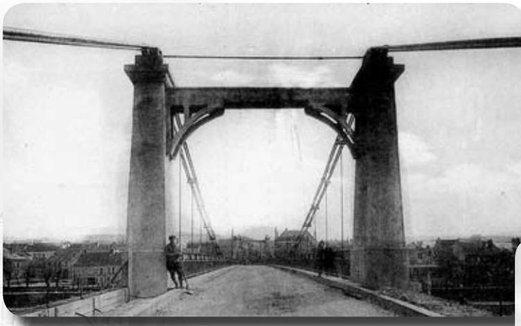
*1931 - À nouveau, la reconstruction d'un pont est entreprise, toujours sur le principe du pont suspendu, photographié là encore depuis la culée rive droite, côté Aisne*
