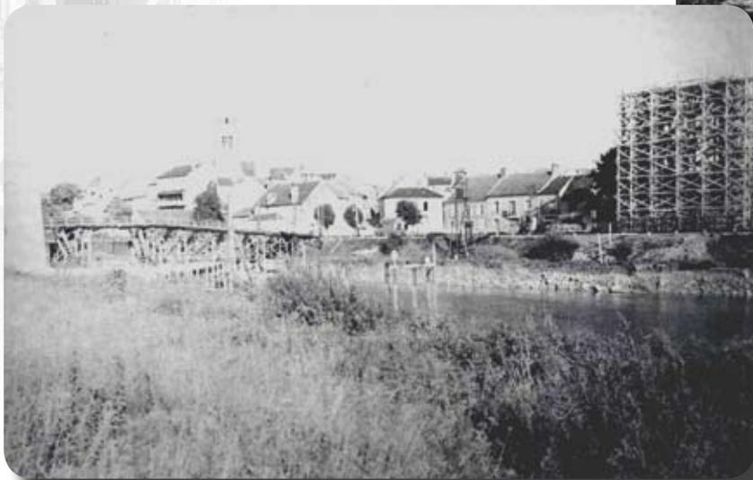
*1949 - C'est la construction de l'ouvrage tel qu'on le connaît aujourd'hui. On aperçoit à droite l'échafaudage pour la construction de deux piliers côté Dormans, et au second plan, la passerelle en bois toujours en usage.*
