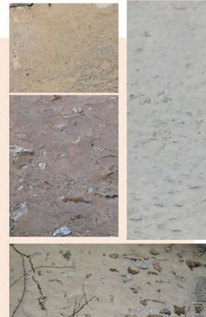
Le grès, le calcaire et plus tardivement la meulière donnent la tonalité du bourg et des hameaux. On retrouve la pierre dans les maçonneries et au sol. Apparente lorsqu'elle est taillée, elle est recouverte d'un enduit plein ou à pierre vue quand elle est en moellons
